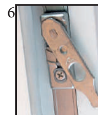
6 Système anti-fausse manœuvre et levier de vantail.
