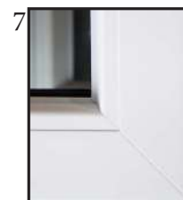
7 Soudure finition grain d'orge. Assemblage en coupe d'onglet.
