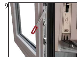
9 Compression et sécurité doublée grâce à la crémone du semi-fixe.
