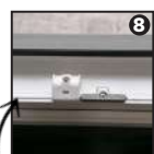
Câble anti-fatigue et jonc de finition en partie basse du dormant
