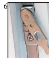
6 Système anti-fausse manœuvre et levier de vantail.
