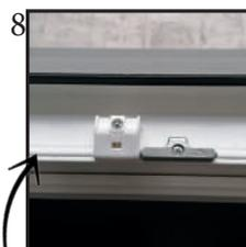
8 Câle anti-fatigue et jonc de finition en partie basse du dormant.
