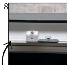
8 Câble anti-fatigue et jonc de finition en partie basse du dormant.
