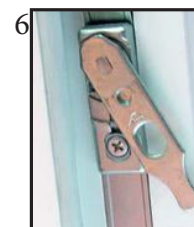
Système anti-fausse manœuvre et levier de vantail.
