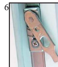
Système anti-fausse manœuvre et levier de vantail.
