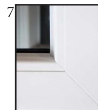
Soudure finition grain d'orge. Assemblage en coupe d'onglet.
