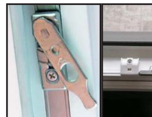
Système anti-fausse manœuvre et levier de vantail sur le semi-fixe.
