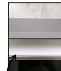
Jonc de finition en partie basse du dormant.
